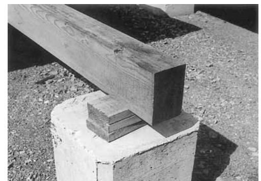
Bild 3: Beispiel für eine Unterlage, die für das Stapeln von Holz errichtet wurde.
